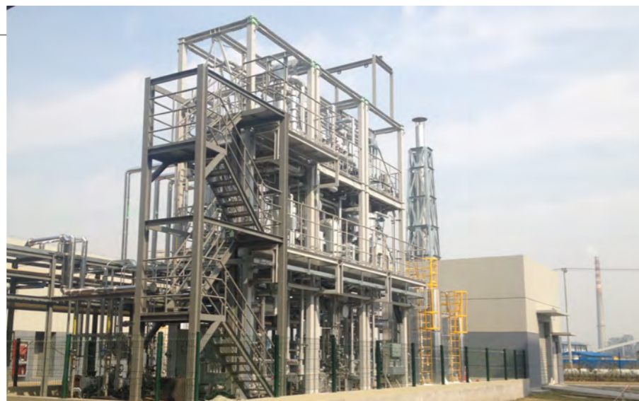
剝離液回收設備
