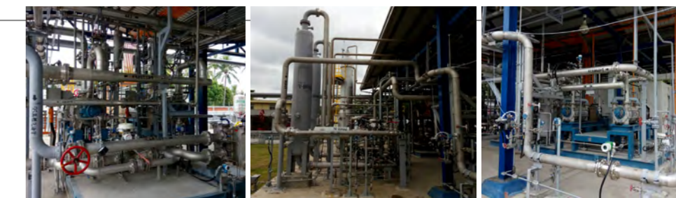
薄膜油氣回收設備
