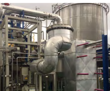
廢液回收再利用設備系統
