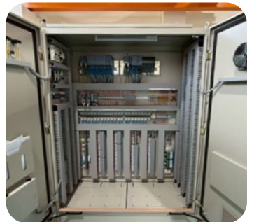
圖 混酸型設備儀表設計改成直流電
