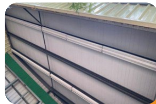
照明設備更換
